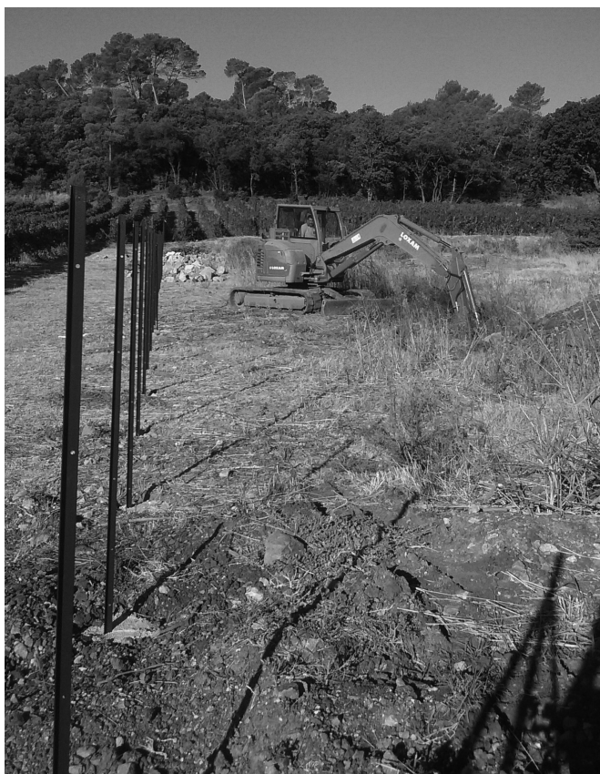
Fig. 7: travaux en cours pour l'installation d'une clôture de protection autour de la Villa antique de Saint-Martin à Taradeau (cl. CAV 2017).
